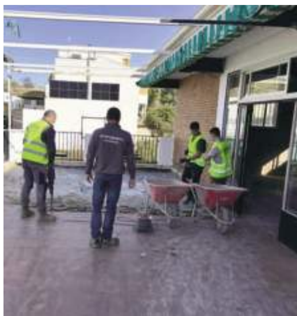
Trabajos en el bar de la Piscina Municipal.
