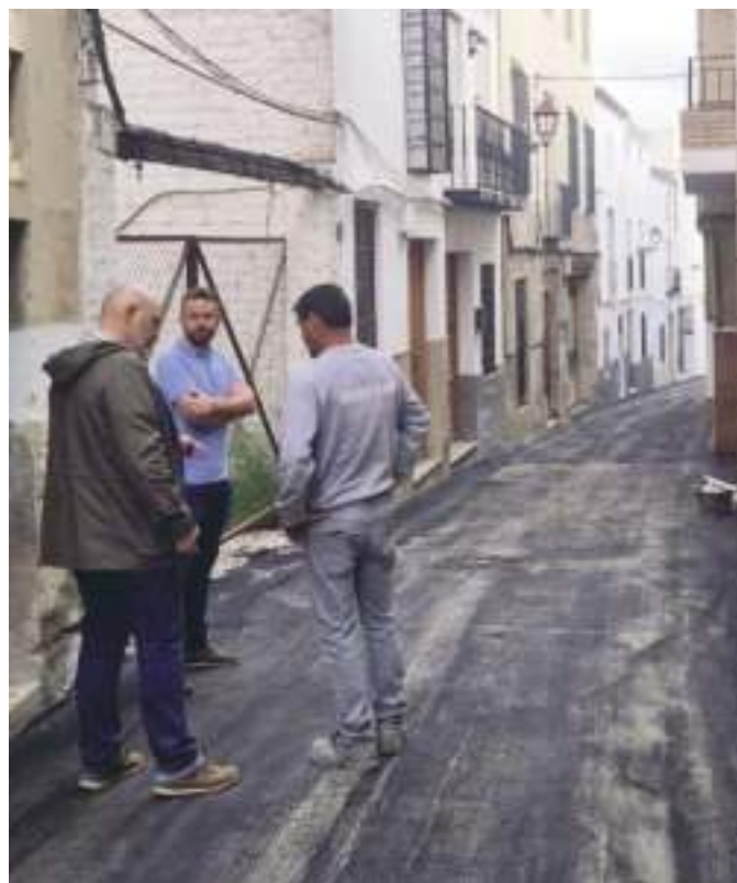
Obras en la calle Nueva.
